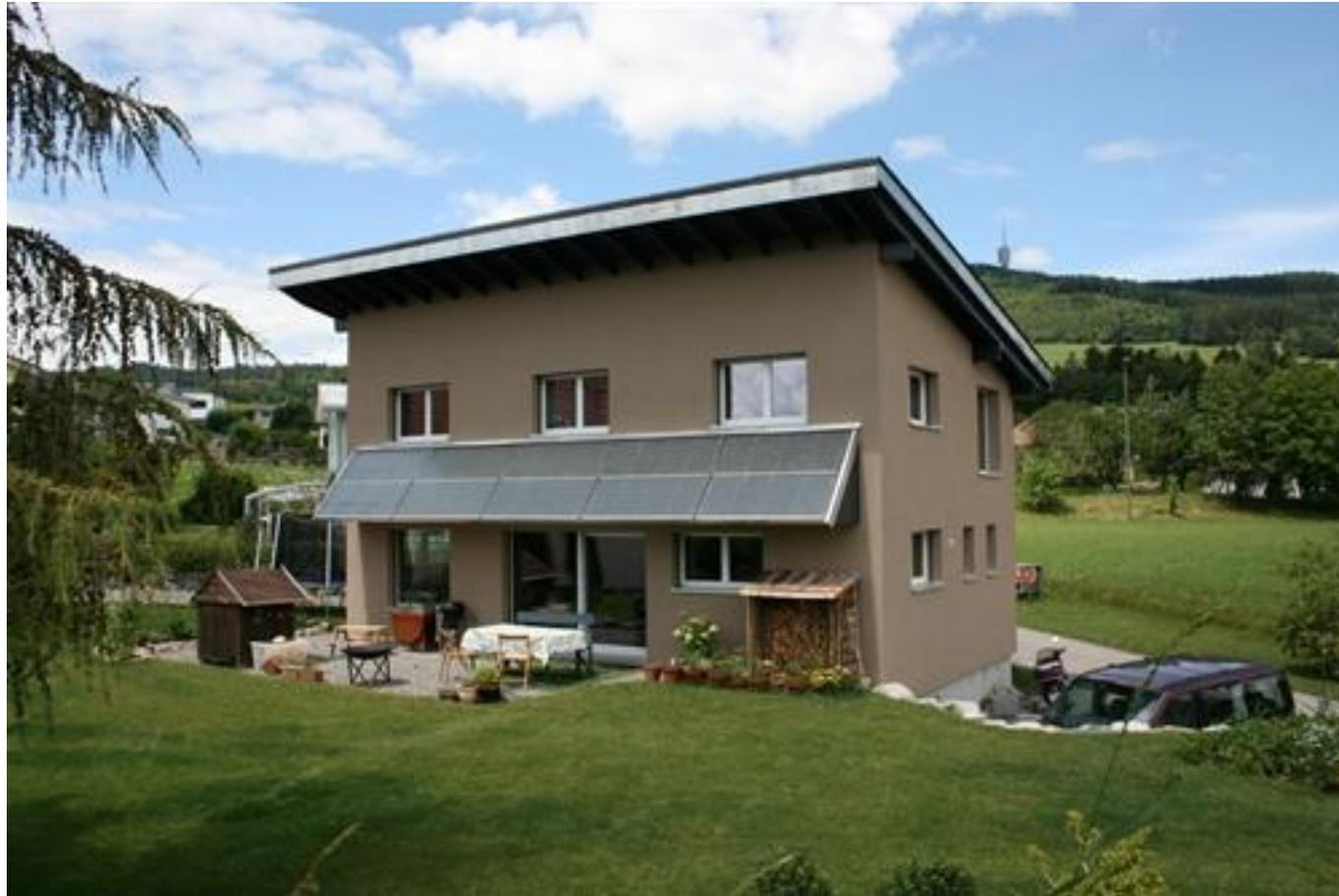
Jaquier, Sorens. Minergie-P à neuf. 180m<sup>2</sup> chauffés. Famille de 6 personnes. 15m<sup>2</sup> solaire, poêle hydro, distribution, ventilation en autoconstruction. Couverture solaire > 80%. Bois < 1 stère/an
